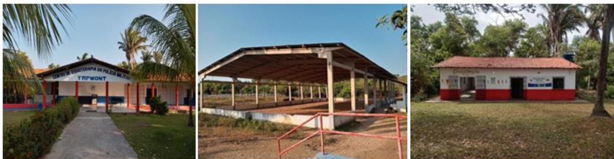
Figura 8: Áreas externas do Centro de Equoterapia da Polícia Militar do Maranhão: Centro de Equoterapia, Picadeiro coberto e Prédio de dança-terapia.
